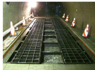
写真-2 鋼製グレーチング
