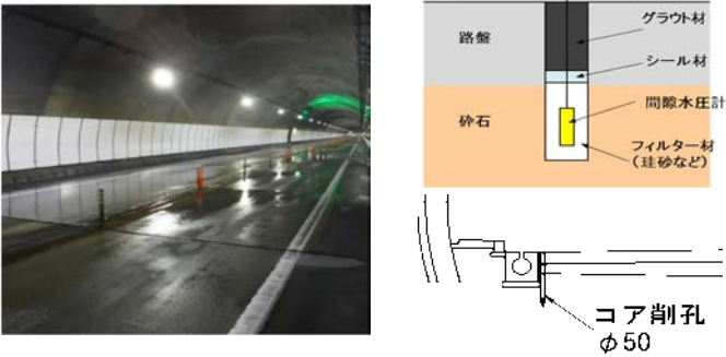
図-4 湧水状況、間隙水圧計、ウィープホール
