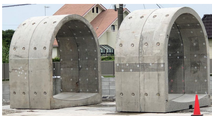
写真-2 試験施工状況
