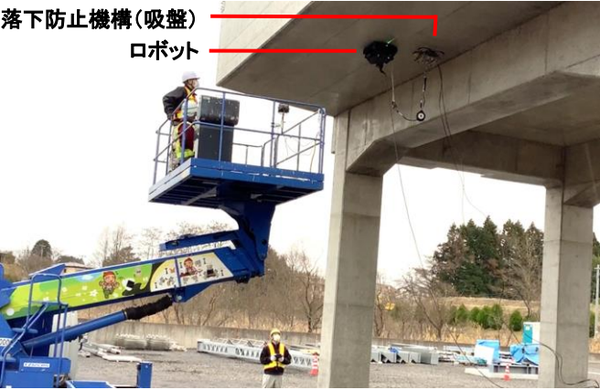
図 4. ロボットによるかぶり測定検証状況
