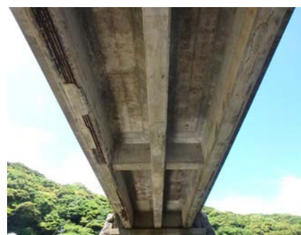
写真 2 桁下全景（桁数：3）
