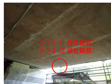
写真-2 外観状況(下 A1-P1)
