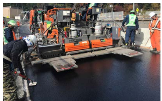
写真-2 BLG 舗設状況（機械施工）
