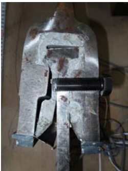
図-5 拘束ボルト破断状況
