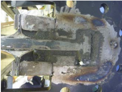
写真－1 グラウト充填後の状況 (No.3)
