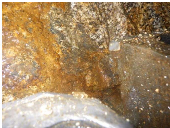
写真-3 風化変質が顕著な岩盤面(232m 付近)
