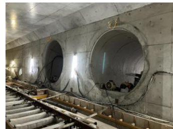
写真-2 推進管設置完了
