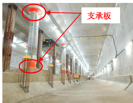
写真-1 合成鋼管柱の設置状況
