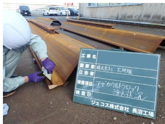
図-2 止水材塗布の様子
