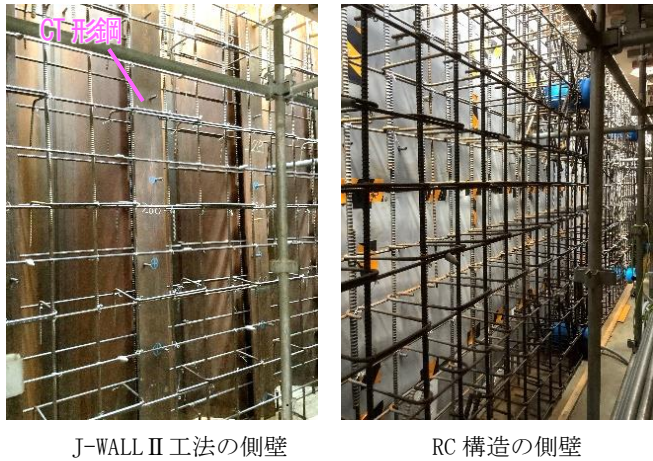
図-4 鉄筋施工状況
