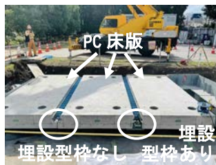
Photo 3 PC床版設置完了
