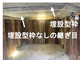
Photo 4 完成後の地下空間
