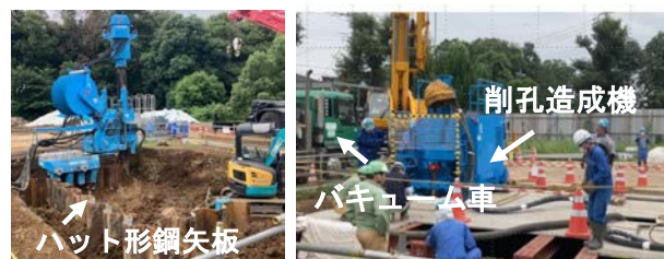
Photo 1 鋼矢板圧入状況
