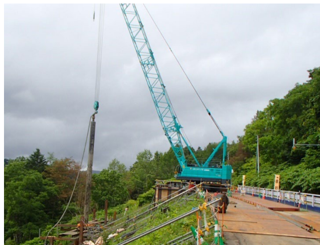
写真-2 クレーン設置状況
