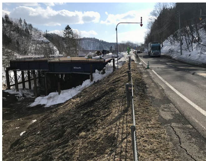
写真-3 B工区状況
