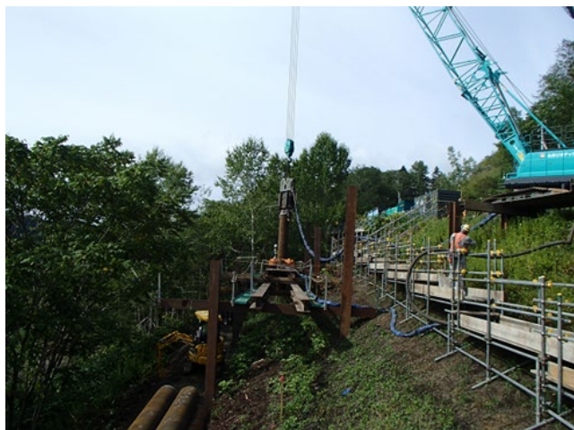
写真-1 A工区状況
