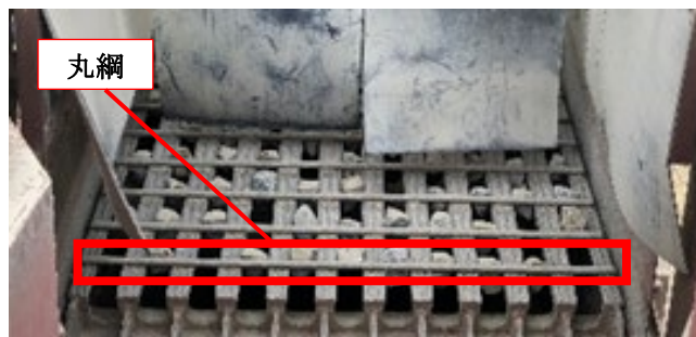
写真3.デッキスクリーンへの丸鋼設置
