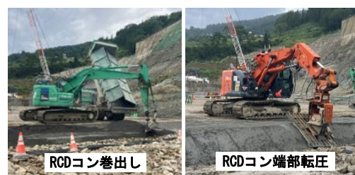
写真-1 施工状況
