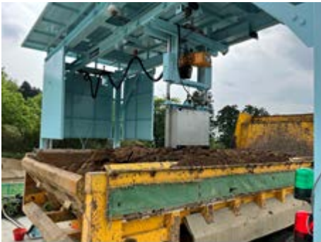
写真-2 含水比計測状況
