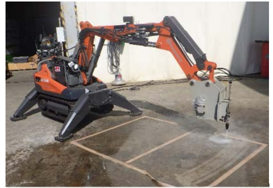
写真-3 ハイウォッシャー試験施工状況
