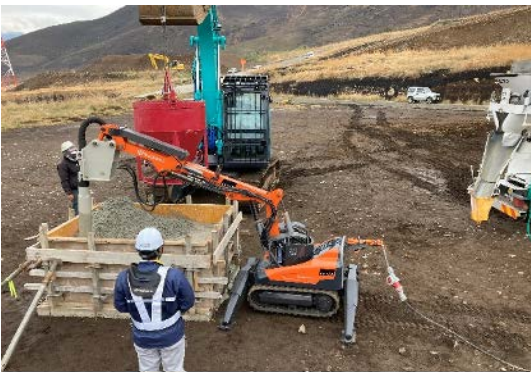
写真-2 コンクリート締固め試験施工状況
