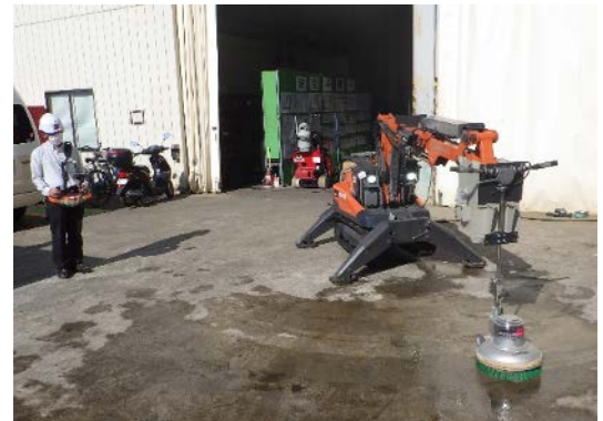
写真-4 ポリッシャー試験施工状況
