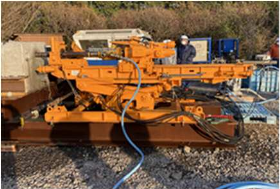
写真-1 気中削孔中のロータリーパーカッションドリル
