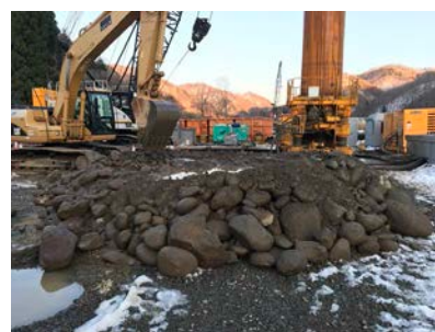
写真-1 掘削により取り出された河床砂礫
