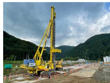
写真-4 ガイドウォール設置状況
