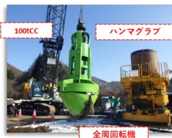
写真-2 置換杭施工状況
