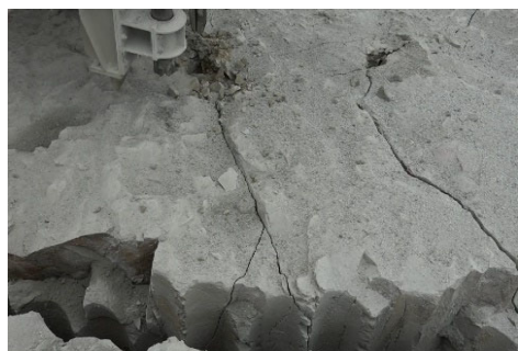
図-6 陸上実証試験（割岩状況）
