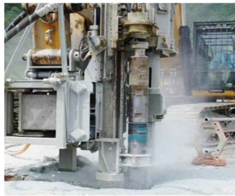
図-5 陸上実証試験（スロット穿孔状況）
