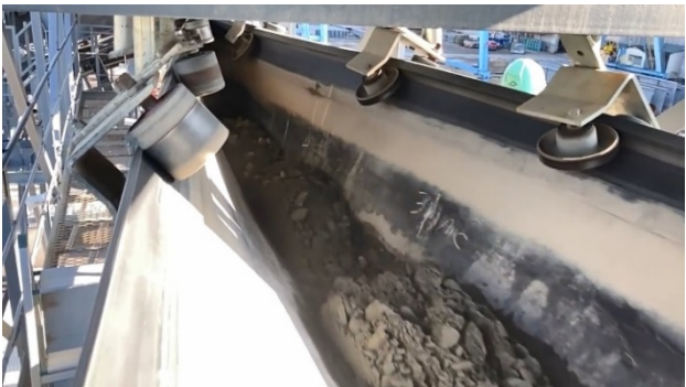
写真-4 上向き運搬試験ベルト内状況
