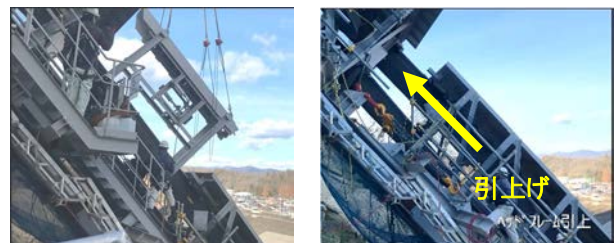
写真-4 フレーム引抜き、引上げ
