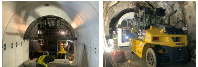
写真 2 PCa 型枠設置状況
