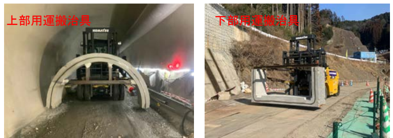
写真 1 PCa 型枠運搬状況
