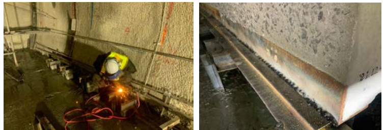
写真 3 レール架台及び PCa 型枠固定状況
