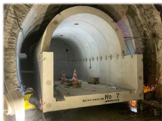
写真 1 PCa 型枠設置状況
