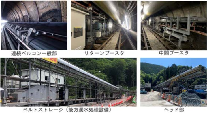
写真-3 連続ベルトコンベヤ設備
