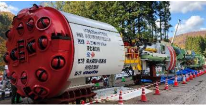
写真-1 TBM 組立完了写真
