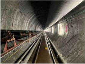
写真-2 坑内状況
