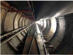
写真-4 TBM 坑内離合箇所
