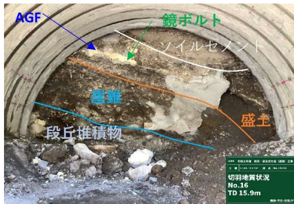
写真－1 トンネル切羽状況
