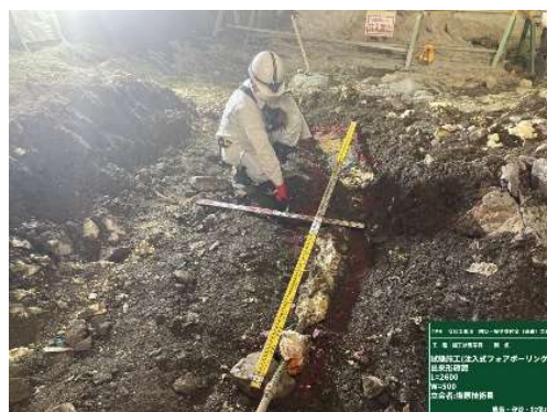
写真－3 試験施工状況
