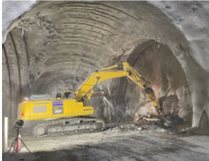
写真－1 起点側本坑掘削時の施工状況
