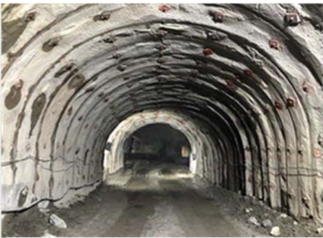
写真—1 避難連絡坑施工完了
