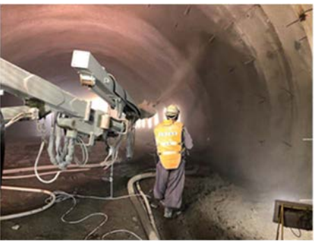
写真—2 吹付覆工施工状況
