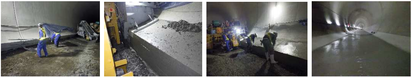
写真-1 チェアー・タイバー設置状況 写真-2 打設状況 写真-3 表面仕上げ状況 写真-4 打設完了
