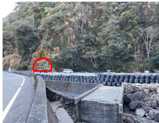
図4 施工前仮設備ヤード全景
