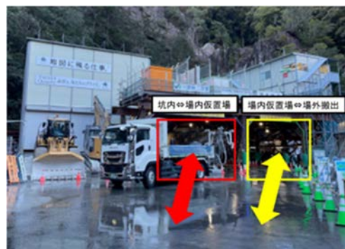
図 9 構台下部に設けた車両動線
