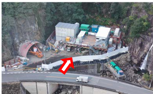
図 7 上空から見た仮設構台
