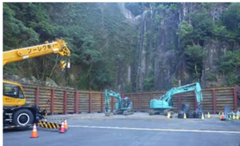
図 5 仮設落石防護柵設置状況
