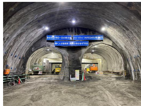
写真-1 低土被り区間
