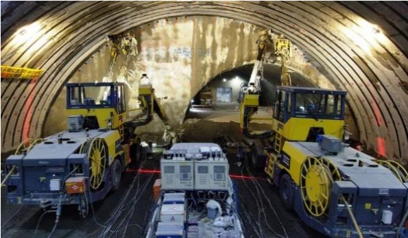
写真－2 AGF 無打撃施工状況
