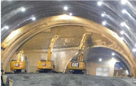
写真-2 掘削状況
