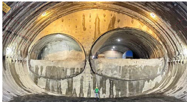
写真－1 日本最大断面の全景
