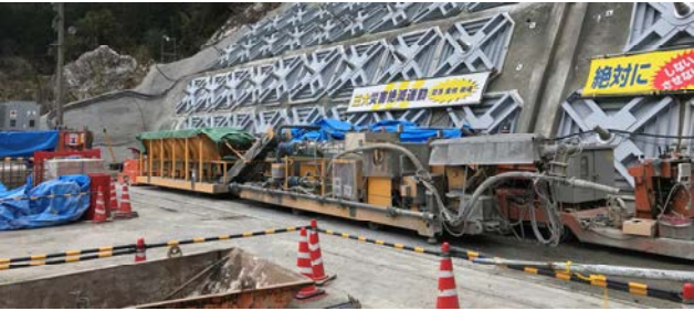
写真-2 吹付け車両編成
