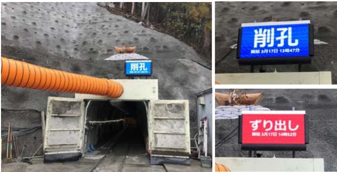
写真-3 坑口部モニター
