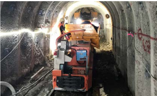
写真-1 標準部掘削状況
