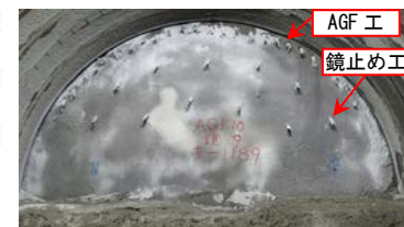
写真-7 切羽安定対策
