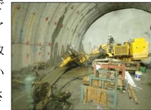
写真-1 水平ボーリング
