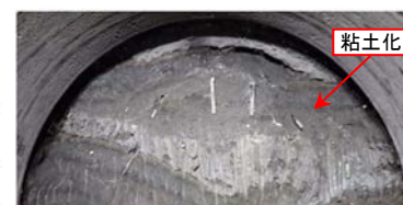
写真-6 切羽状況
