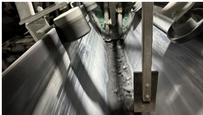
写真-4 ずり供給部および過積載防止センサー
