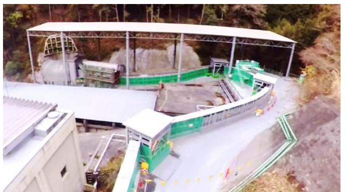
写真-2 コンベヤ設置状況（トンネル方面）
