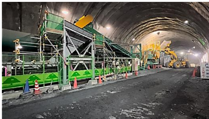
写真-3 坑内ずり仮置き場
