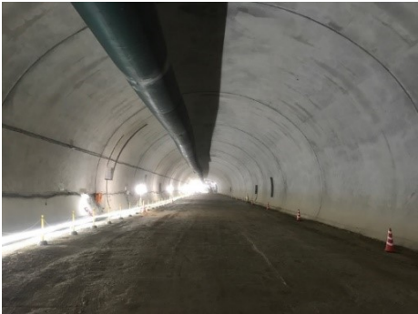
写真1 繊維補強覆工施工完了区間
