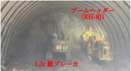
写真-1 機械掘削状況(No.52+38)
