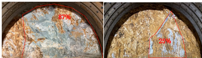
写真-4 NO.53+01 発破掘削の範囲 写真-5 NO.53+27 発破掘削の範囲
