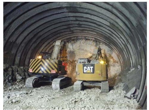
写真-2 本坑掘削状況
