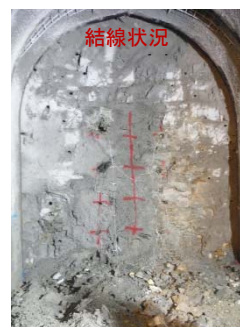
写真-4 非火薬岩盤破碎状況
