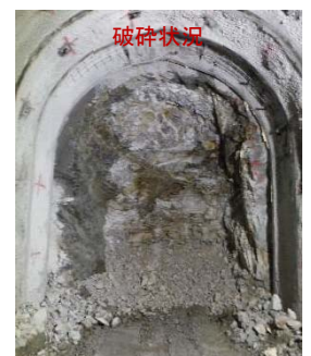
写真-4 非火薬岩盤破碎状況
