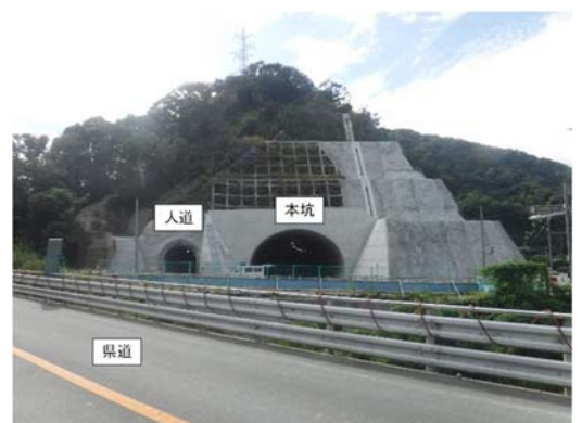
写真-5 本坑掘削状況
