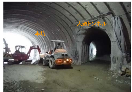
写真-3 人道トンネル掘削状況
