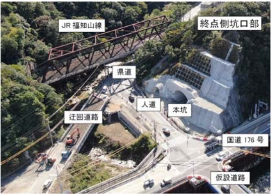
写真-1 終点側坑口部全景
