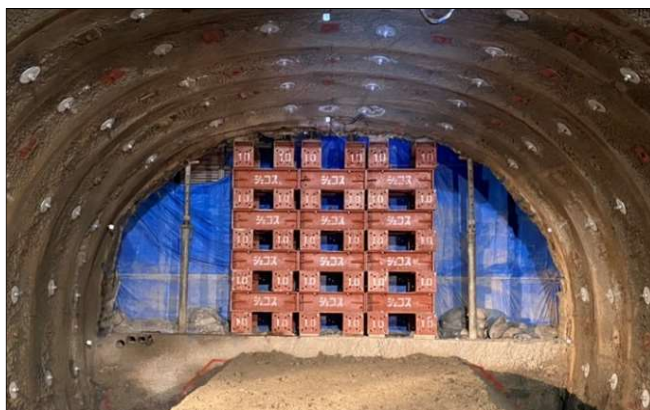
写真-1 サンドルによる山留材での補強（上り線側）
