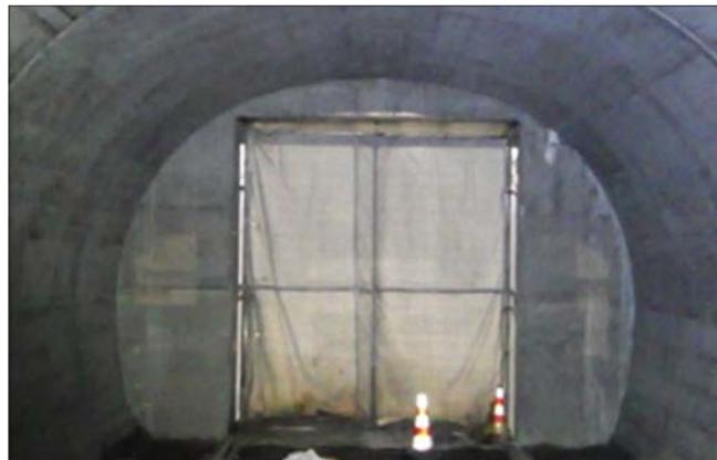
写真-2 補強工の完成状況
