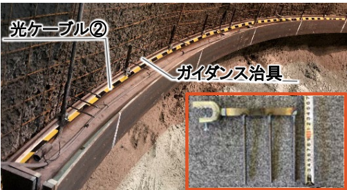
写真-1 ガイダンス治具設置
