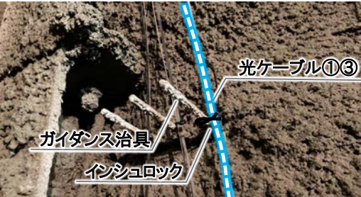
写真-2 光ケーブル設置
