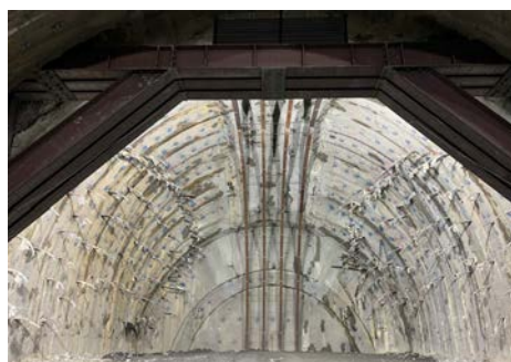
写真-2 門型支保工施工状況
