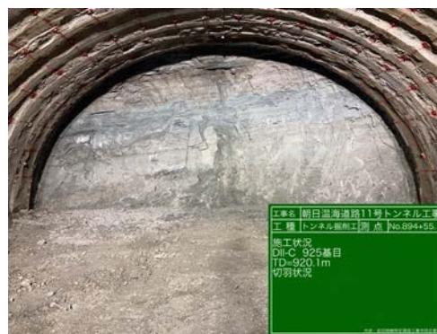
写真-2 切羽写真(到達点)
