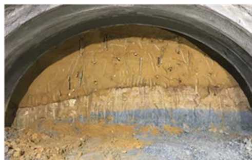
写真-2 切り羽状況
