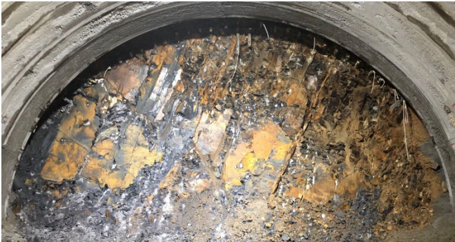
写真 2 切羽状況（No.129+24,TD21m）
