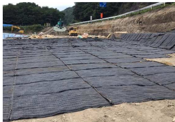
図-4 対策盛土 吸着マット敷設状況
